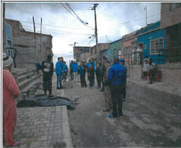
FOTO 1 REUNION DE FINALIZACION TESORITO EN SITIO DE OBRA
