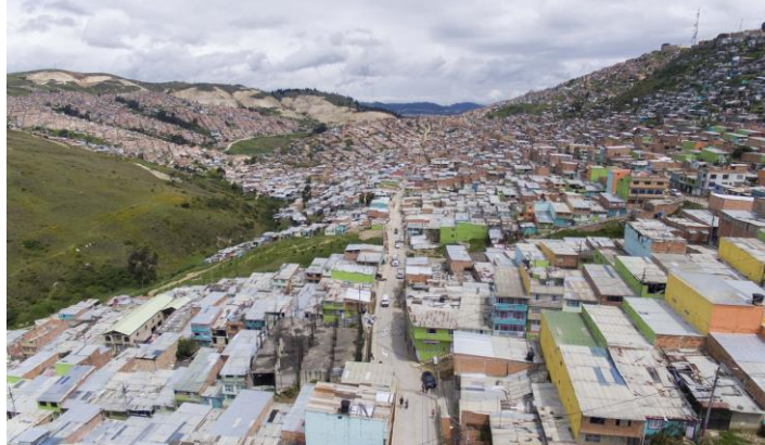
El corredor vial construido (conformado por 13 segmentos viales – CIV) en el barrio Caracolí de la localidad de Ciudad Bolívar.
