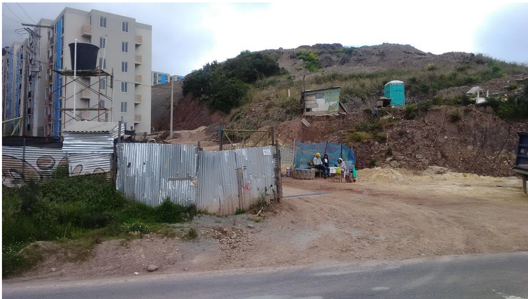
Ilustración 8 Se observa disposición de rellenos varios hacia el costado sur de la urbanización Santa Teresita.
