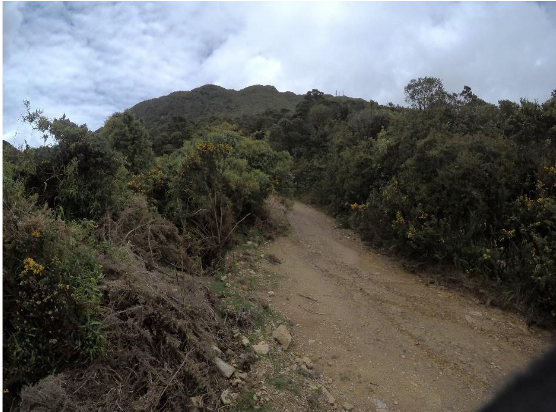
Ilustración 9 Vía existente conocida como el “Camino Ancestral Puente de Piedra”, el cual conduce a la parte alta de la ladera. Se observa desarrollo de focos de erosión laminar y en surcos.
