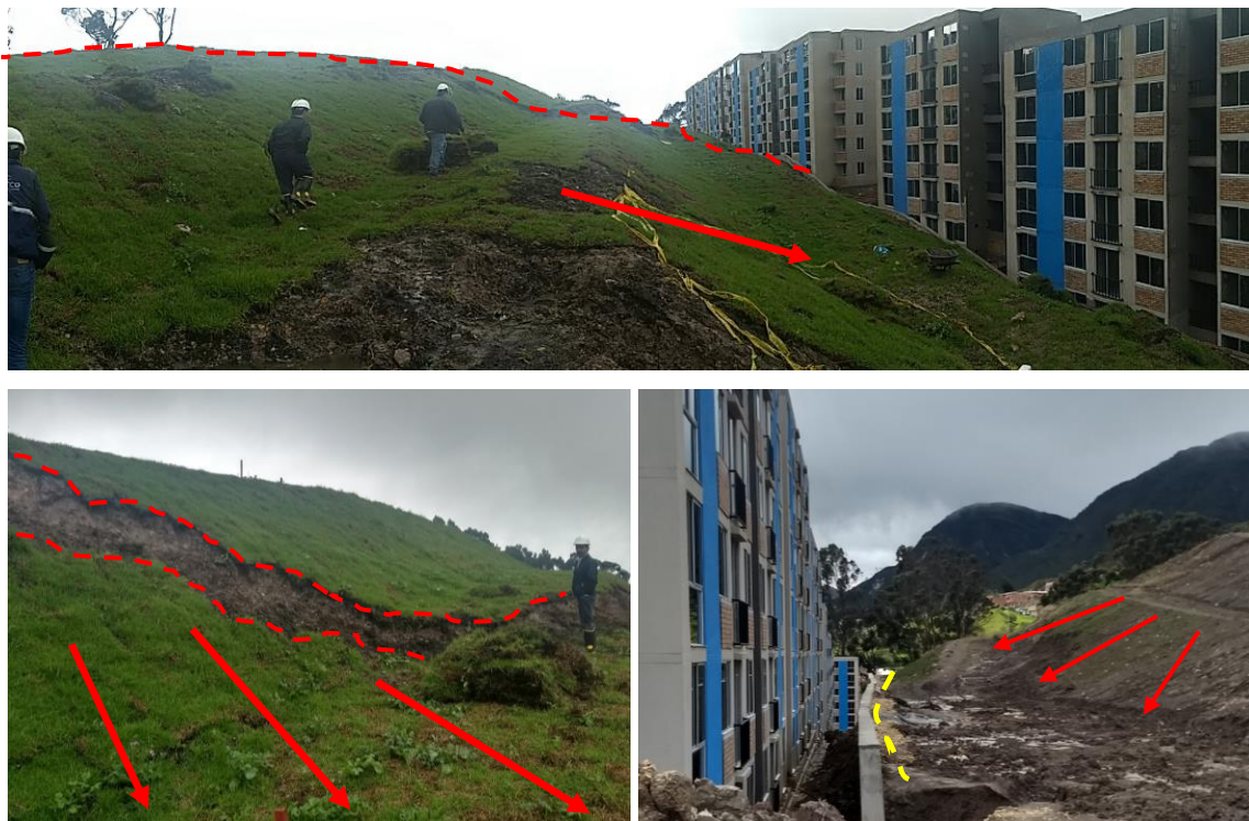
Figura 2 Proceso de inestabilidad que afecta la parte alta de la urbanización Santa Teresita y a un tramo de la Línea Quindío – Juan Rey de la red de acueducto. Se resalta en rojo el escarpe de falla y la dirección del movimiento. En amarillo se resalta la deformación que presenta uno de los muros de contención contiguos al sector afectado por el proceso de inestabilidad.
