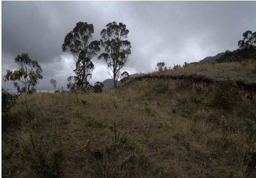
Ilustración 10 Se observa corte de trazado de vía en ladera en depósito coluvial.
