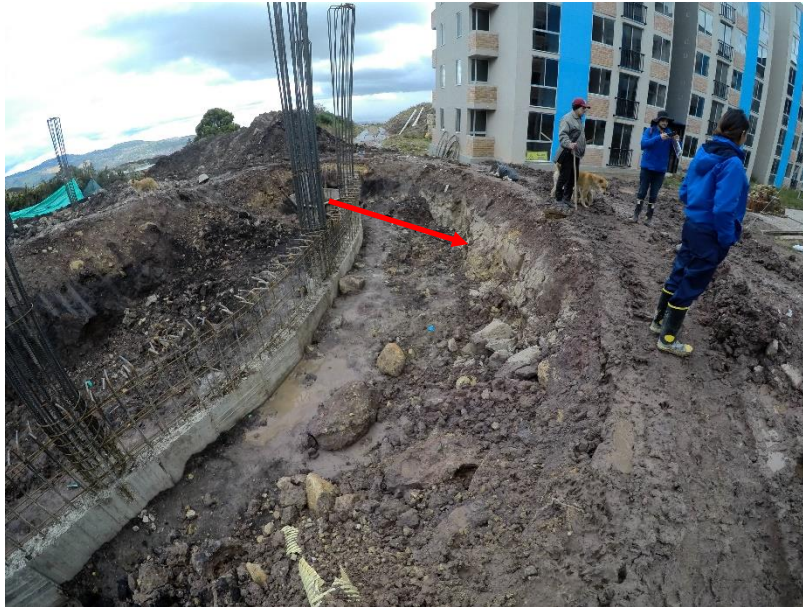
Ilustración 5 Se observa ventana en arcillolitas de la Formación Bogotá en sector de obra.
