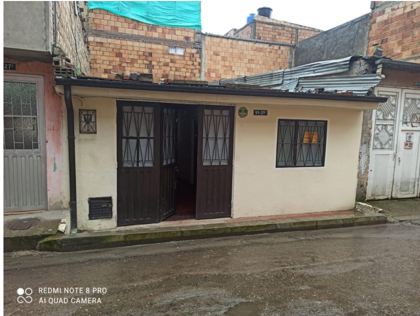
Foto 1: Fachada de la vivienda
