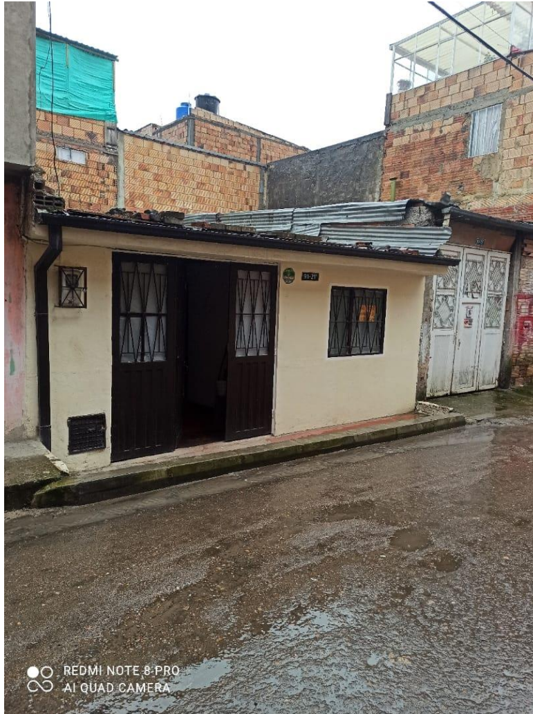
Foto 2: Fachada de la vivienda
