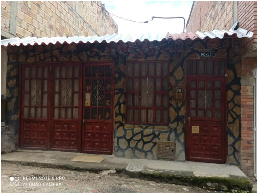
Foto 1: Fachada de la vivienda
