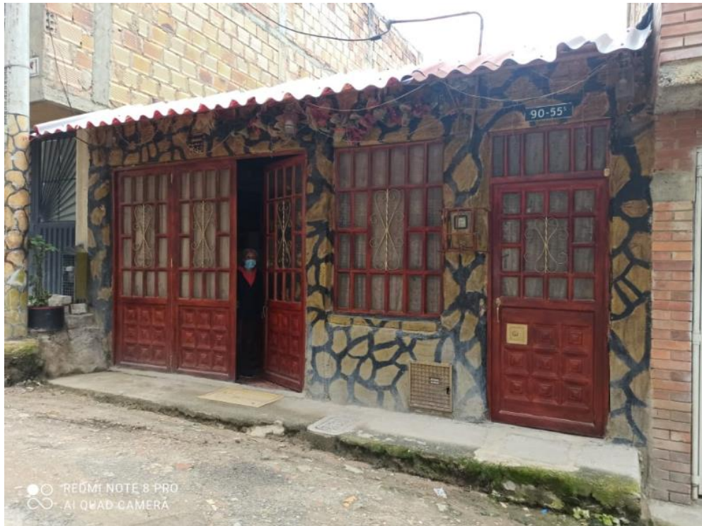
Foto 2: Fachada de la vivienda
