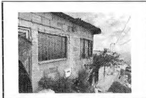
Instalación de vidrios para ventanas
