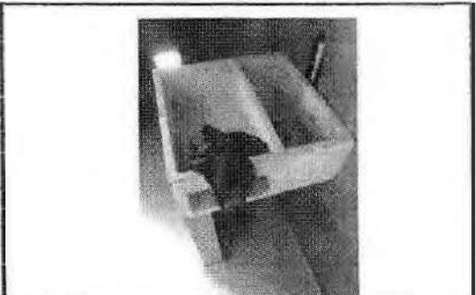
Construcción de muro para lavadero
