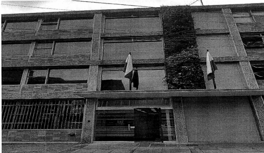
Fachada ingreso principal a la CVP
