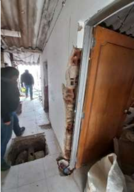
Remoción de muros, pañetes y modificación de diseños.
