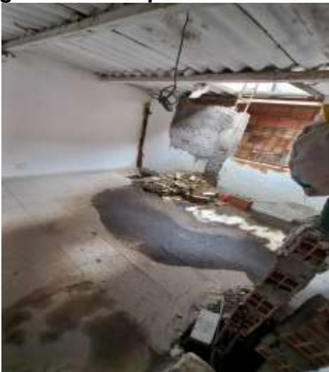
Remoción de muros, entrepiso, pañetes y modificación de diseños
