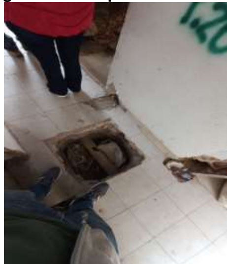
Excavación de caja de inspección.
