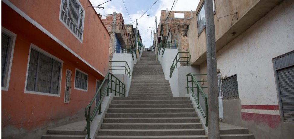
Ilustración 11 Construcción de escaleras Localidad Usme
