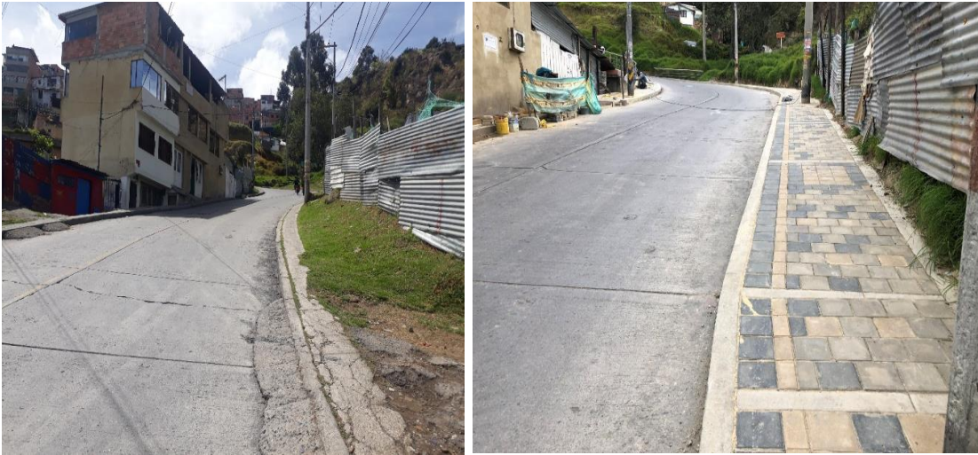
Ilustración 13 Vías construidas en Villa Nidya
