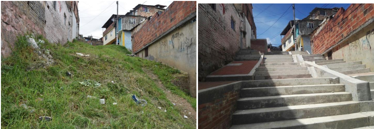
Ilustración 15 Obras en San Cristóbal
