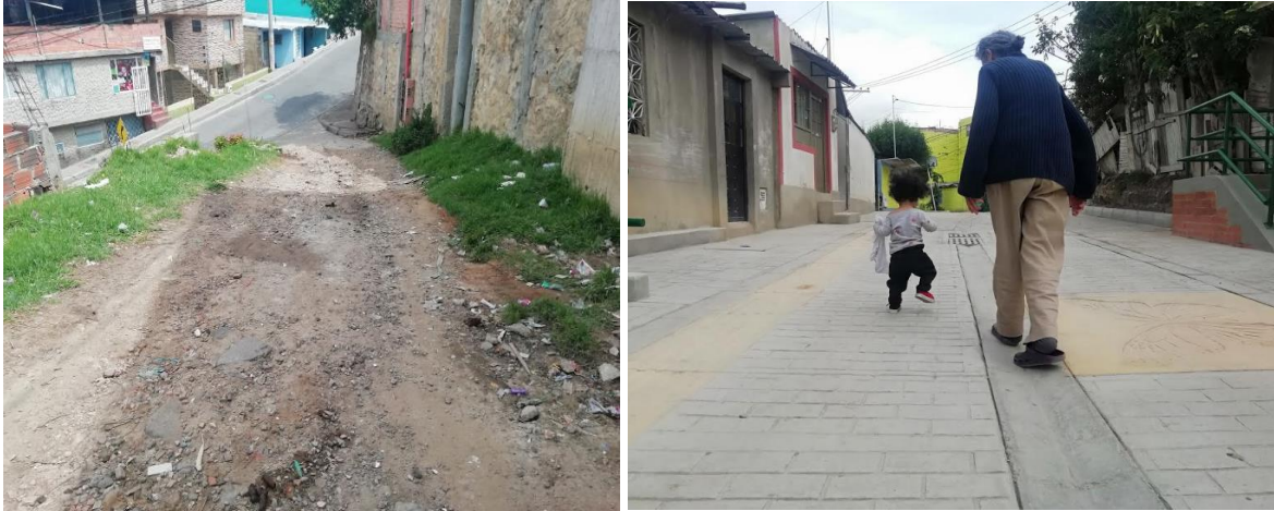
Ilustración 18 Corredor vial en construcción barrios Cerro Norte y Santa Cecilia
