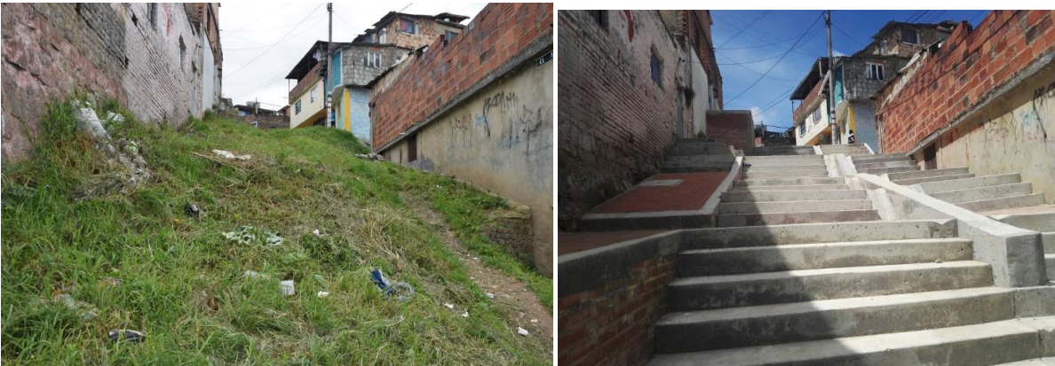
Ilustración 15 Obras en San Cristóbal
