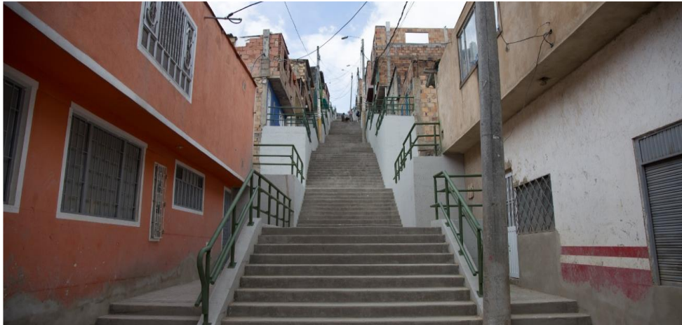
Ilustración 11 Construcción de escaleras Localidad Usme
