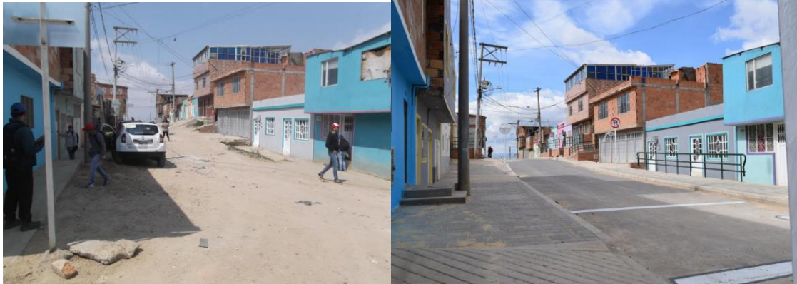
Ilustración 20 Corredor vial en construcción barrio Arabia
