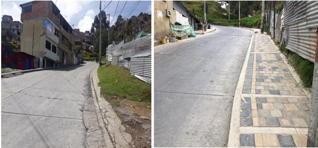
Ilustración 13 Vías construidas en Villa Nidya
