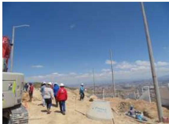
Pozos de red pluvial y conformación de la alameda.
