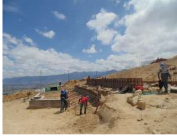
Conformación y estructura para las graderías del teatrino.
