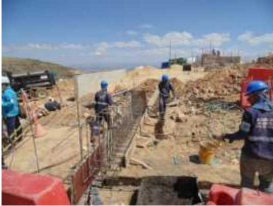
Armado de hierros para muro de contención, cancha múltiple.
