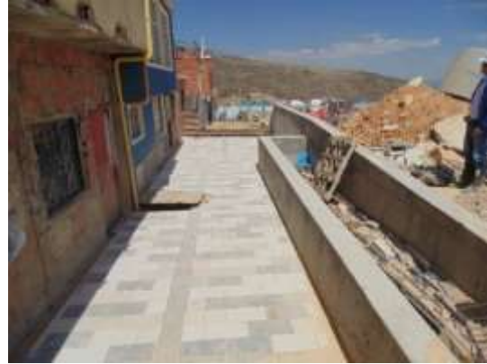
Contenedor de raíces, muros de contención y paños de espacio público de la alameda perimetral, frente a culatas de viviendas.
