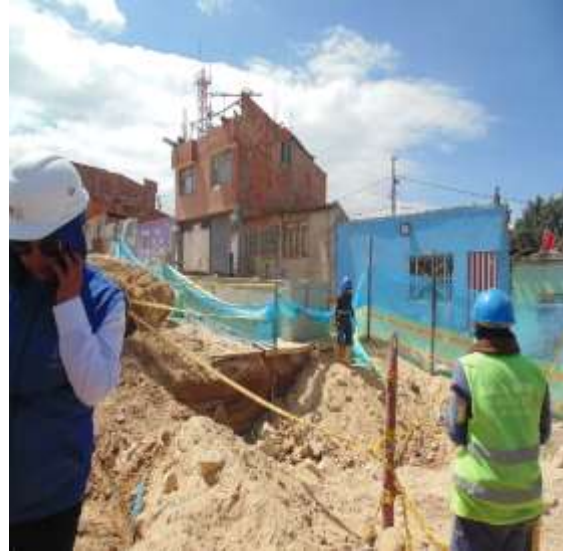
Excavaciones y conformación de la alameda perimetral contra las culatas de las viviendas.
