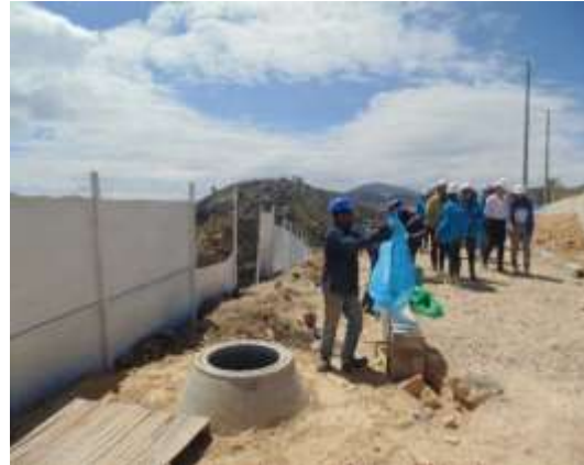
Pozos de alcantarillado pluvial. Bordillos alameda perimetral del Mirador.
