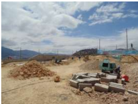
Conformación y nivelación para la cancha de fútbol.
